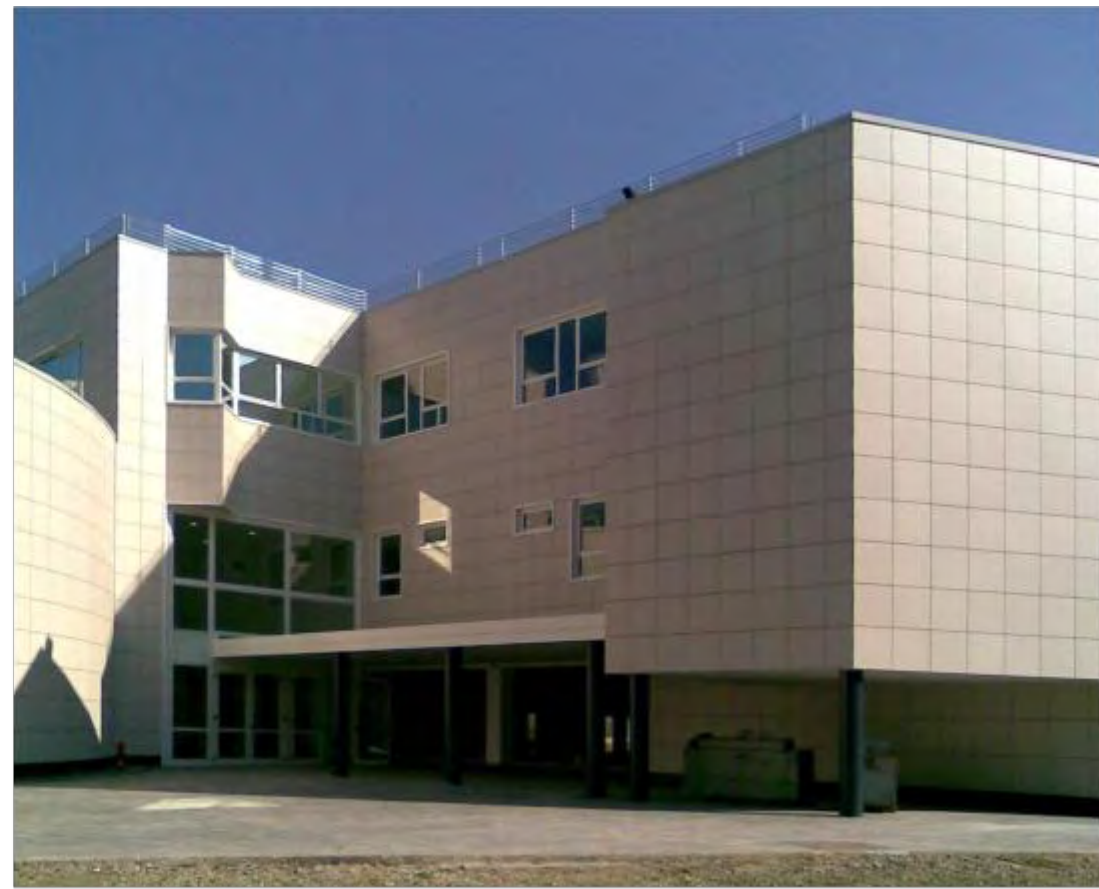
74 - tranche A la façade sud terminée
