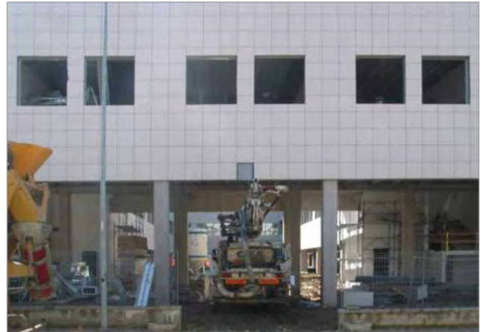
34 | 35 - tranche C réalisation de la façade nord e coin nord est laboratoires de recherches grands engins et chambre chaude
