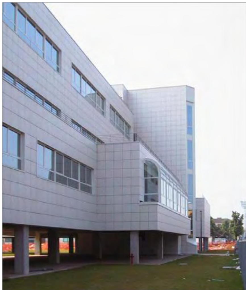
17 - tranche B façade est en évidence la vitrée de la salle des étudiants
