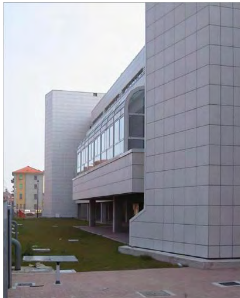
18 - tranche B façade est la salle des étudiants entre les deux escaliers ouest
