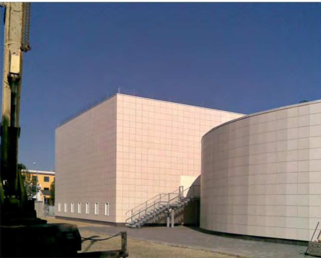
73 - tranche A façade sud le volume de la salle conférences et la tholos du hall
