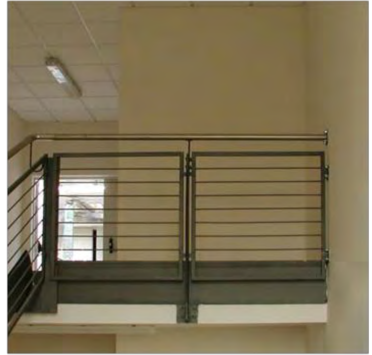
20 | 21 | 22 | 23 - tranche B l'un des quatre escaliers
