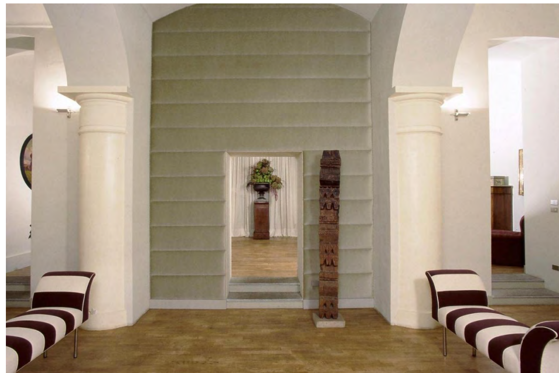
3 - les colonnes d'origine retrouvées dans les murs qui séparaient les trois pièces réunies par le projet
